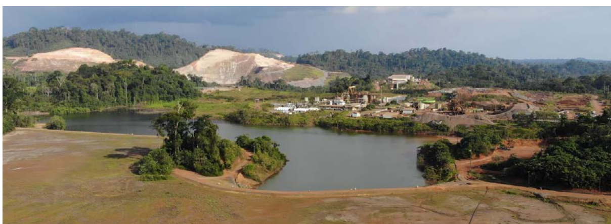
Imagem 3 – Imagem obtida por drone de toda a unidade operacional localizada em Pedra Branca do Amapari/AP
