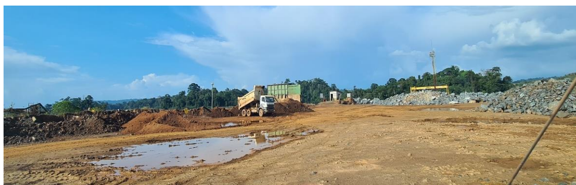
Imagem 15 – Preparação/manejo de minério para estocagem/processamento
