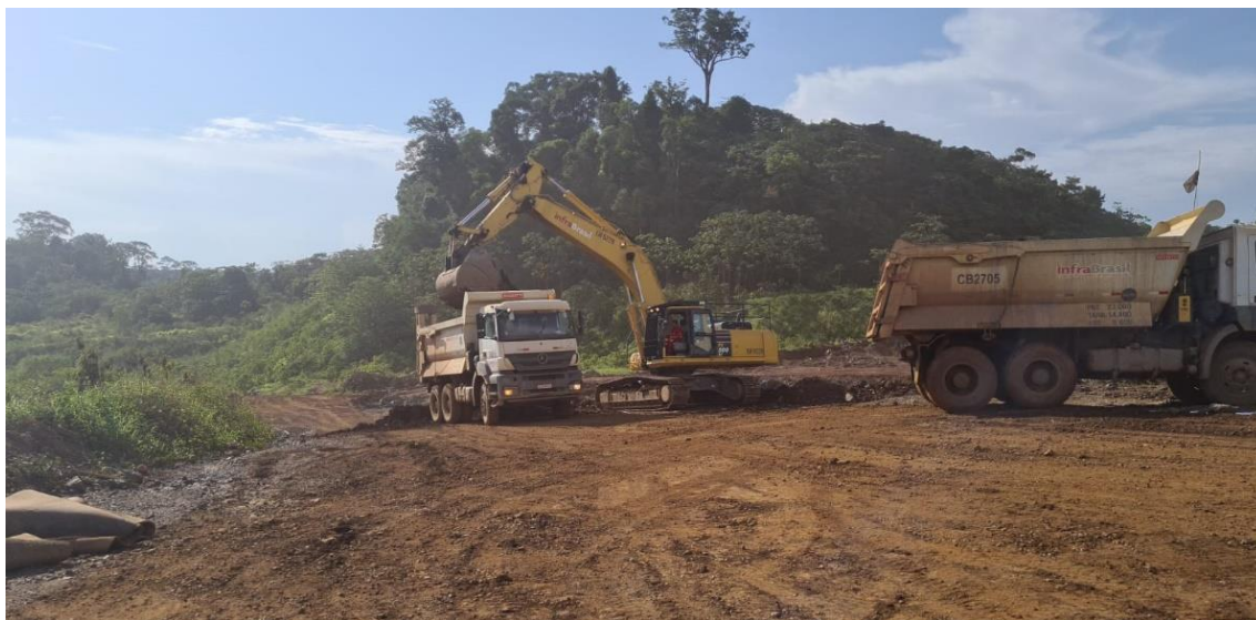
Imagem 14 – Preparação/manejo de minério para estocagem/processamento
